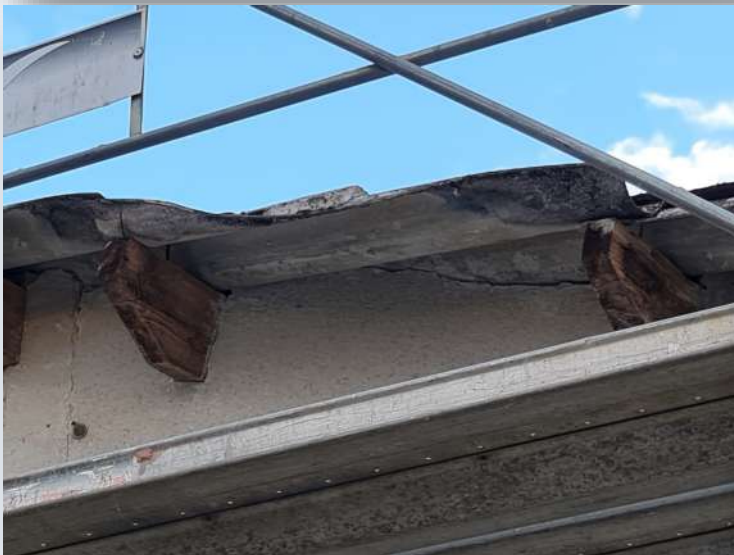
Les panneaux en éverite amiantée apparaissent sous les tuiles Côté place abbé Élias
